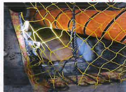
污水池留置口
