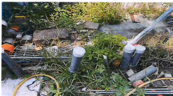
工地未完工前汗水孔留置口建議先加蓋處理
