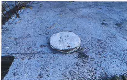
工地未完工前，汗水孔留置口建議先封口或加蓋處理
