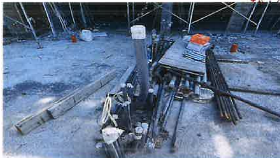
工地未完工前汗水孔留置口建議先加蓋處理
