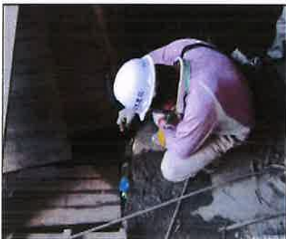
車道下方水溝
