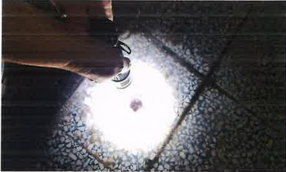
地下室排水孔
