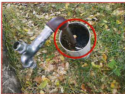
水龍頭管柱凹槽
